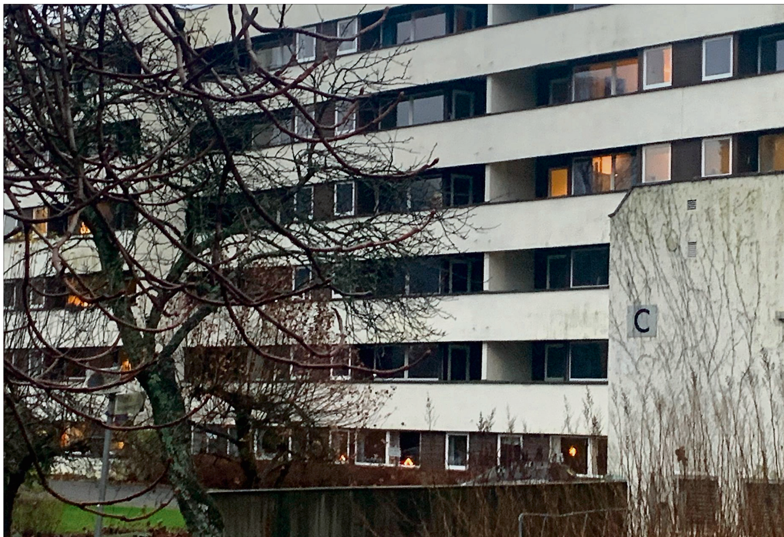
Bygget beskrives som nedslitt, trist og uverdigg for dets formål - rehabilitering av pasienter.
